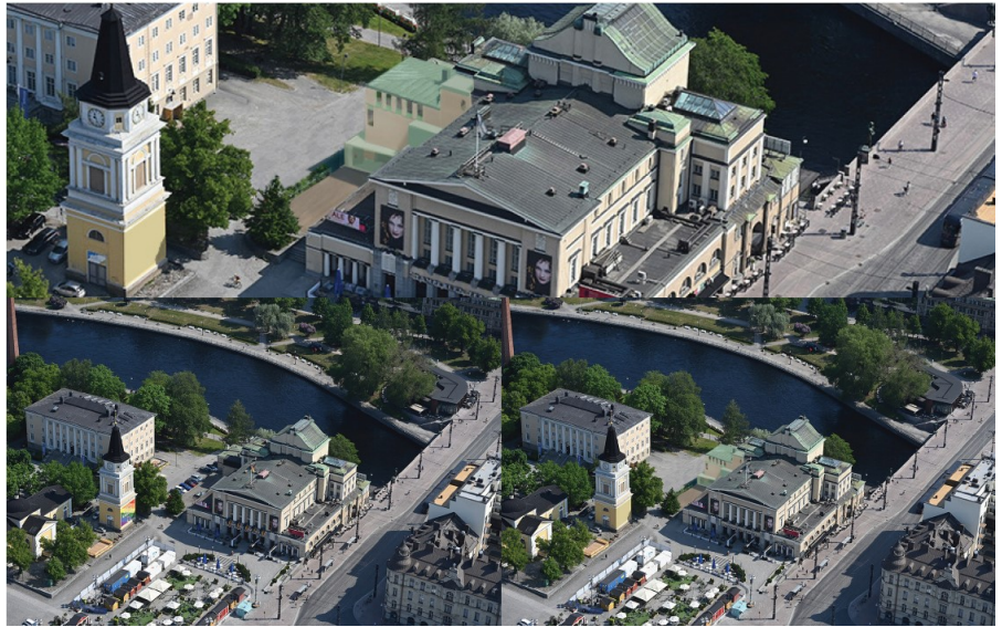
Kuva 18 Viistokuvissa on esitetty teatteri ja viitesuunnitelma. Alla vasemmalla nykytila, alla oikealla ja yllä suurenoksessa viitesuunnitelman mukainen uusi laajennus nykyisen teatterin pohjoispuolella. Kuvissa teatterin vasemmalla puolella Vanhan Kirkon kellotapuli ja Vanha kirjastotalo, nyk. kulttuuritalo Laikku. Laajennuksen edessä Keskustorin puolella on terassitilaa. Viistokuva ©2015 BLOM. Kopiointi kielletty. Viitesuunnitelma Arkkitehtitoimisto Forssi Oy 2024.
